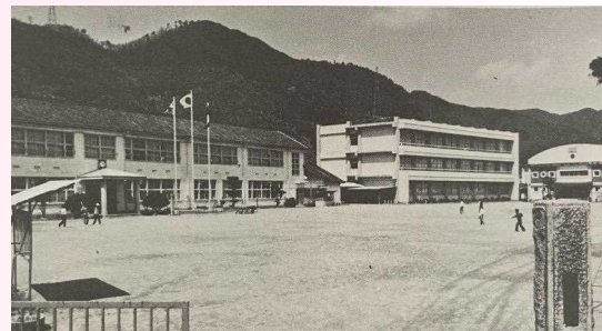
木造2階建て校舎横に 鉄筋3階建て新校舎
